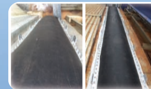
หลังติดตั้ง
