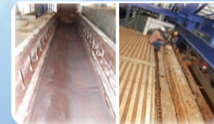
ก่อนติดตั้ง
